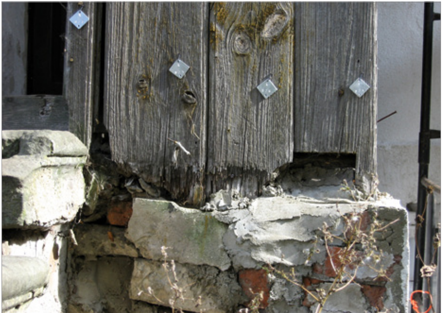
Fot. 7. Kuczka, prace inwentaryzacyjne i rozbiórkowe/stan zachowania, Szydłowiec 2006, fot. A. Stankowski / Muzeum Historii Żydów Polskich POLIN
