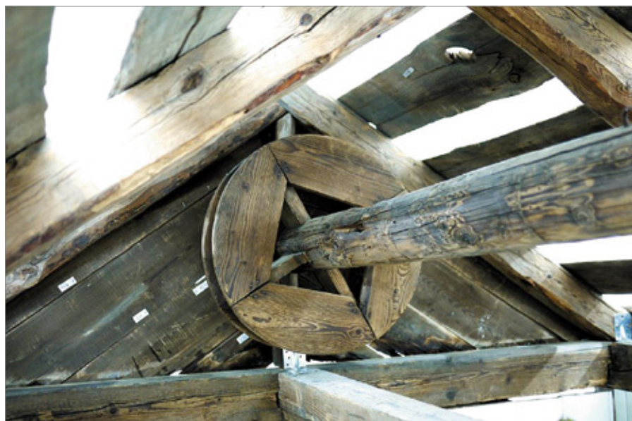
Fot. 10. Kuczka, kołowrót z mechanizmu do otwierania dachu kuczki po konserwacji, a, fot. A. Wielocha, C.D. Martin.
