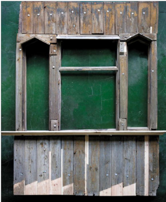
Fot. 9. Kuczka, ściana kuczki po wykonaniu uzupełnień drewna, fot. A. Wielocha, C.D. Martin.
